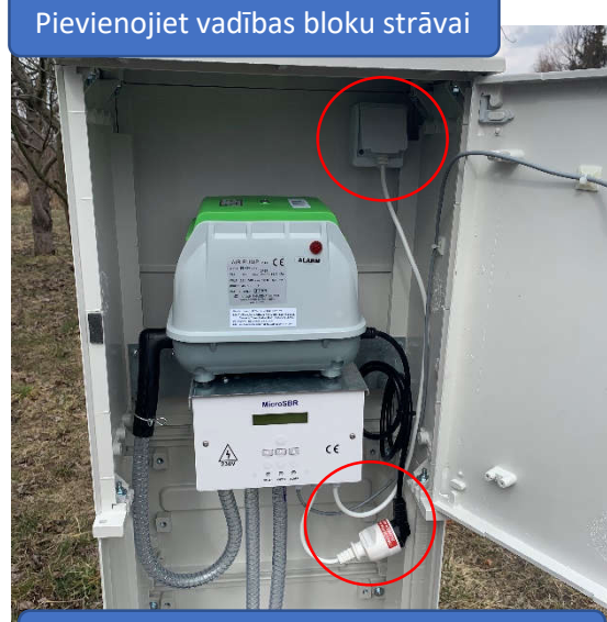
Pievienojiet kompresoru vadības blokam
