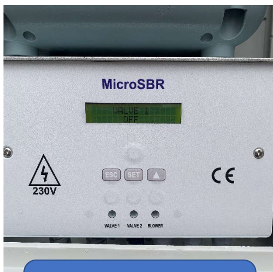
Vārsts 1 Notekūdeņu aerācija - difuzors BALTS
